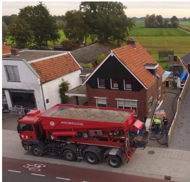
Figuur 3.8 Het aanbrengen een zand-bentonietmengsel door Van Heteren (bron : Van Heteren)
